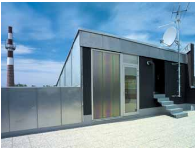
7 — 2X9bytové domy v Polici nad Metují / Sřešní objekt
