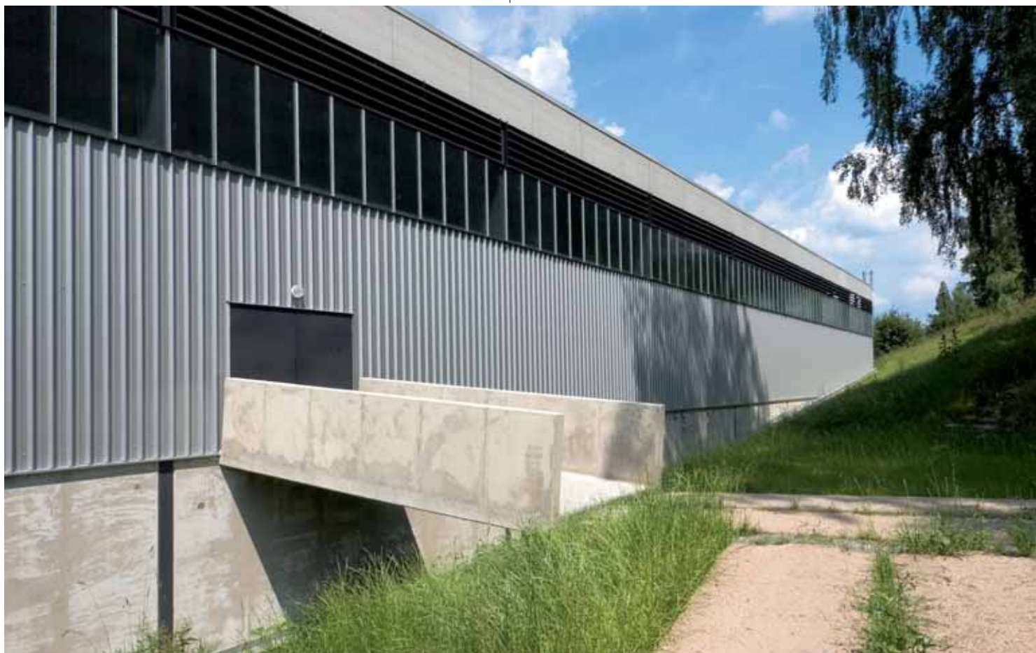
Pohled z východu
